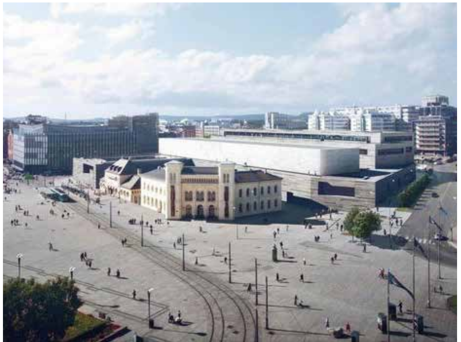
Det nye Nasjonalmuseet på Vestbanetomta i Oslo får kjøling og oppvarming fra sjøvannet i Oslofjorden
