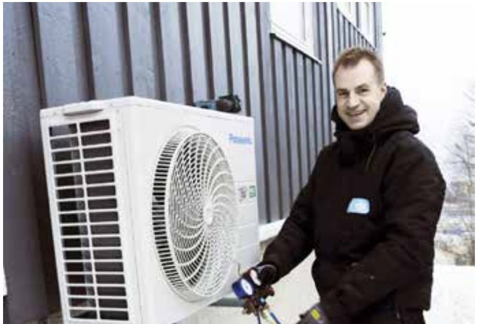
Lang erfaring: Montør Runar Jørgensen har bestemt seg for at det er plass til varmepumpe i hvert eneste hus. Etter 12 år i jobben har han ennå ikke vært nødt til å skuffe en eneste kunde.
