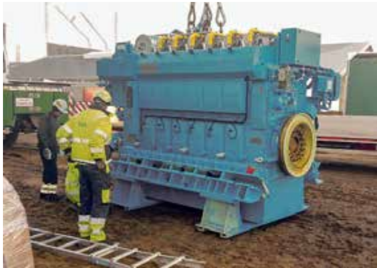
Varmepumpen er fremstillet i Norge på licens for Rolls Royce og er den første af sin art med skruekompressor. Foto: Brande Fjernvarme
