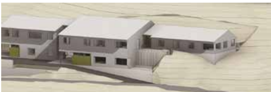
Statsbygg mener BIM og andre digitale tiltak er gode verktøy for å få til en mer effektiv byggeplass. (Foto: Statsbygg)
