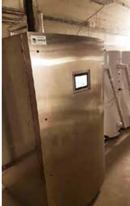
CO 2 -varmepumpen på Møllergata skole i Oslo. Foto: Undervisningsbygg
