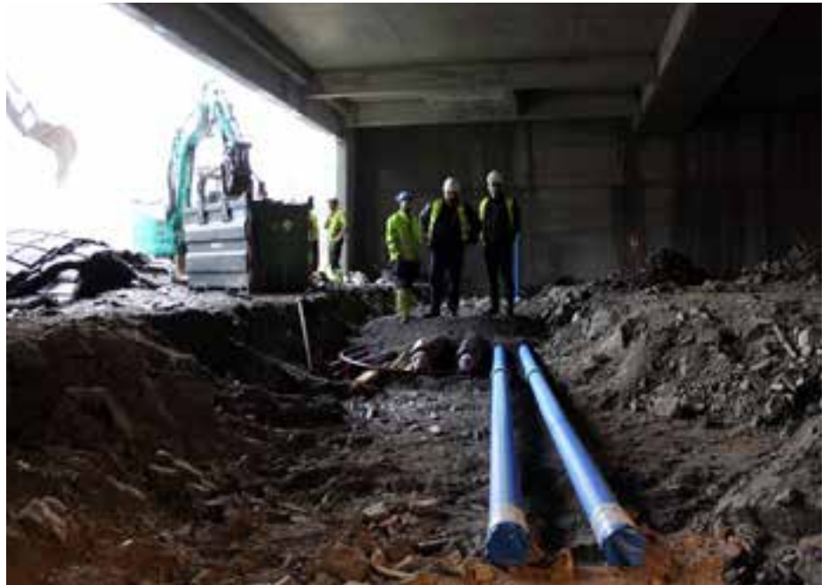
Her blir det lagt frem BluePipe Pre isolerte rør til isbane lagt i grunn frem mot isbane.
