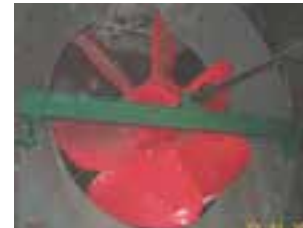
En av de to store dampdrevne viftene med sirocco vinger
