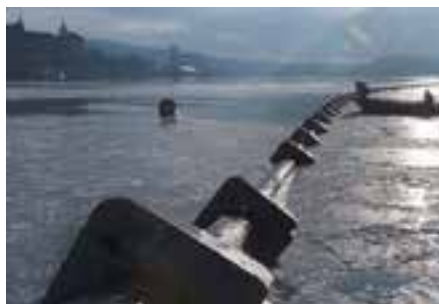
Vannrøret ble slept og sveiset på plass sist vinter, før det ble senket.
